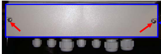
Abbildung 11 Entfernung der Abdeckung von den Anschlüssen
